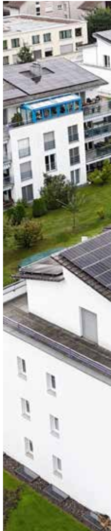
Solaranlage bei der Überbauung Florapark
