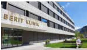
Berit Klinik, Notfallzentrum, Tagesklinik und Spezial- sprechstunden 9630 Wattwil
