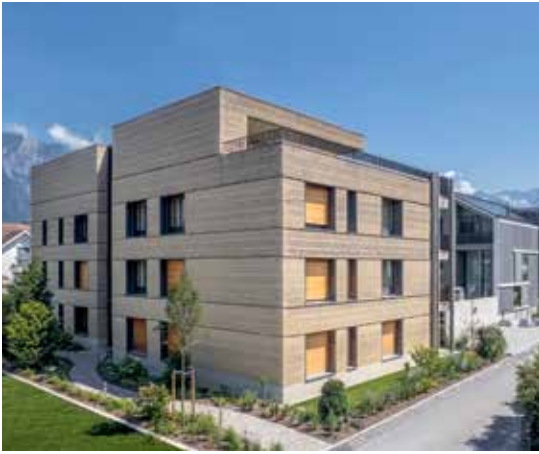
Lehmbau, Haus der Freunde.
