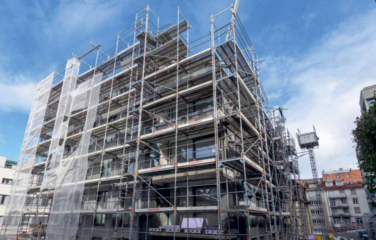
Der Haldenhof in St.Gallen.
