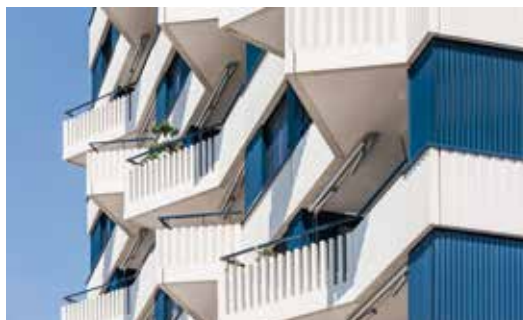
Das Beispiel Bachstrasse Kreuzlingen zeigt 1 von 7206 Möglichkeiten, die mit Betonelementen machbar sind.
